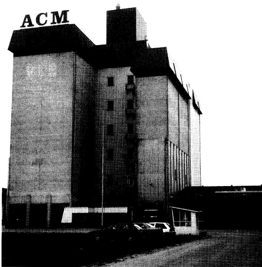
Sinds vijf jaar is onze ATV-repeater, 75 meter boven NAP, gehuisvest in het ACM gebouw, een veevoederfabriek in Emmen. De directie heeft ons toestemming verleend om de ATV-repeater op de bovenste verdieping te plaatsen. Een 10 meter lange kantelmast, op de foto net zichtbaar, staat op de top van het gebouw. (foto: Piet Sloot, PA3FRZ)
